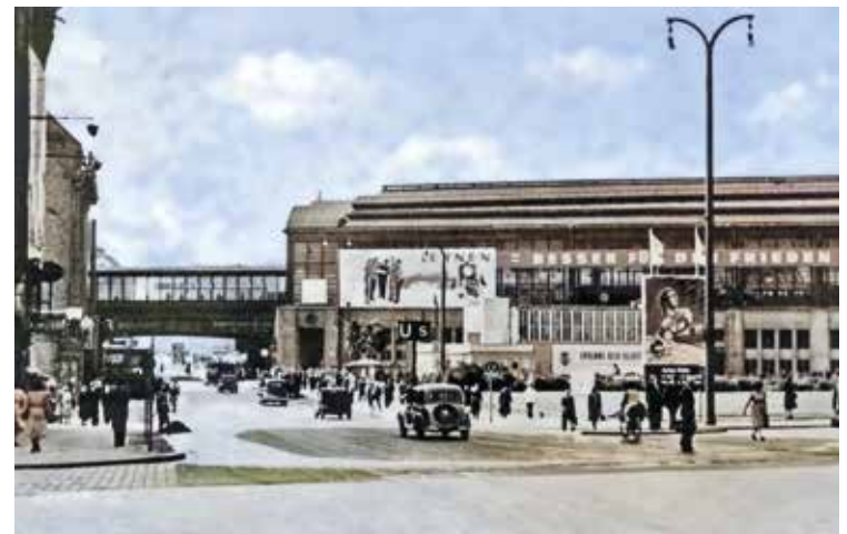
Fern- und S-Bahnhof Friedrichstraße auf einer historischen Ansichtskarte aus den 1950er-Jahren
