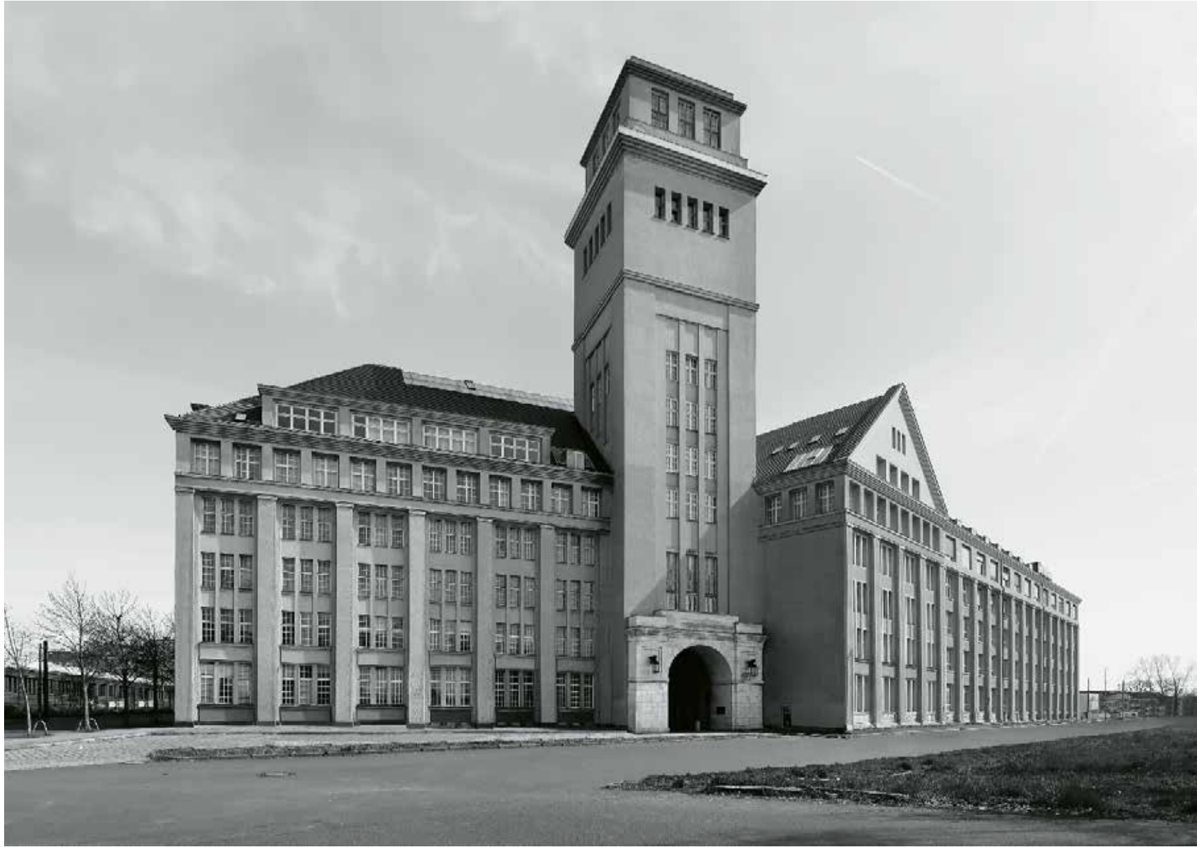
Berlin-Oberschöneweide, Behrensbau, Ostendstraße / Wilhelminenhofstraße, Peter Behrens, Baujahr 1917
