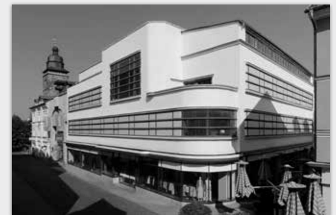
Gotha, ehemaliges Kaufhaus »M. Conitzer und Söhne«, heute Moses Kaufhaus, 1928–29, Bruno Tamm
